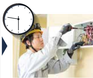
9:30 現場入り 休憩を取りながら、夕方まで工事作業を進めます。
