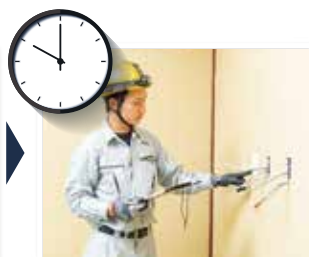
10:00 現場入り お客様のご要望に応えながら、作業員に指示を出して現場を管理します。
